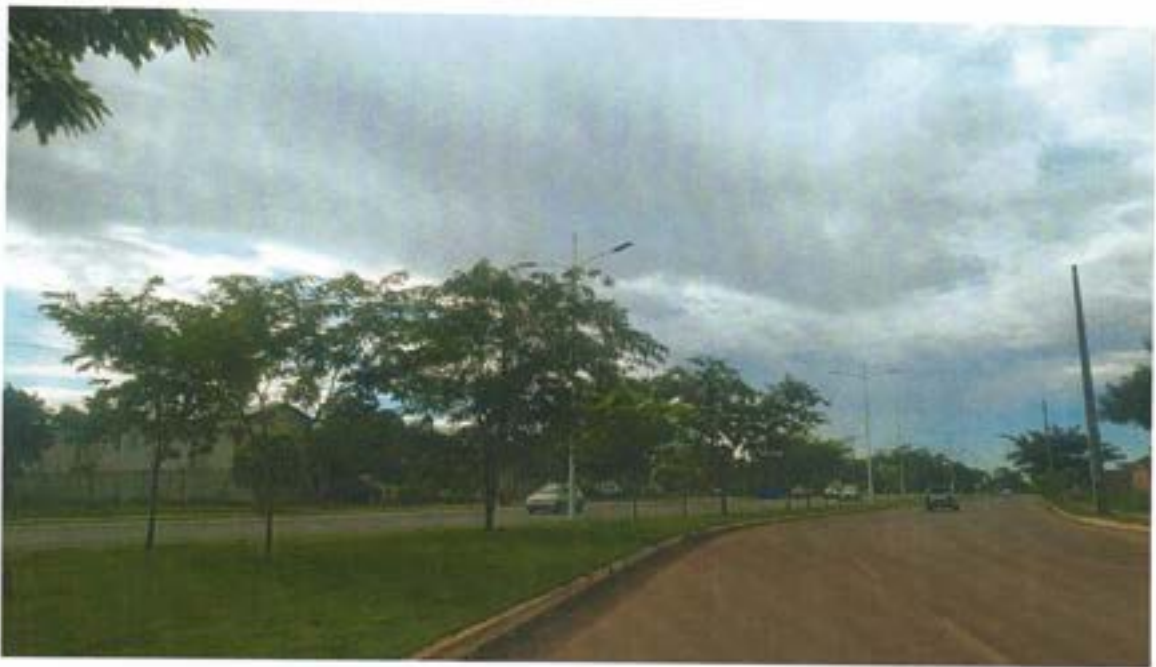
Figura 60 - AV. NS - 04 - ENTRE AV. LO - 29 E AV. LO - 31
